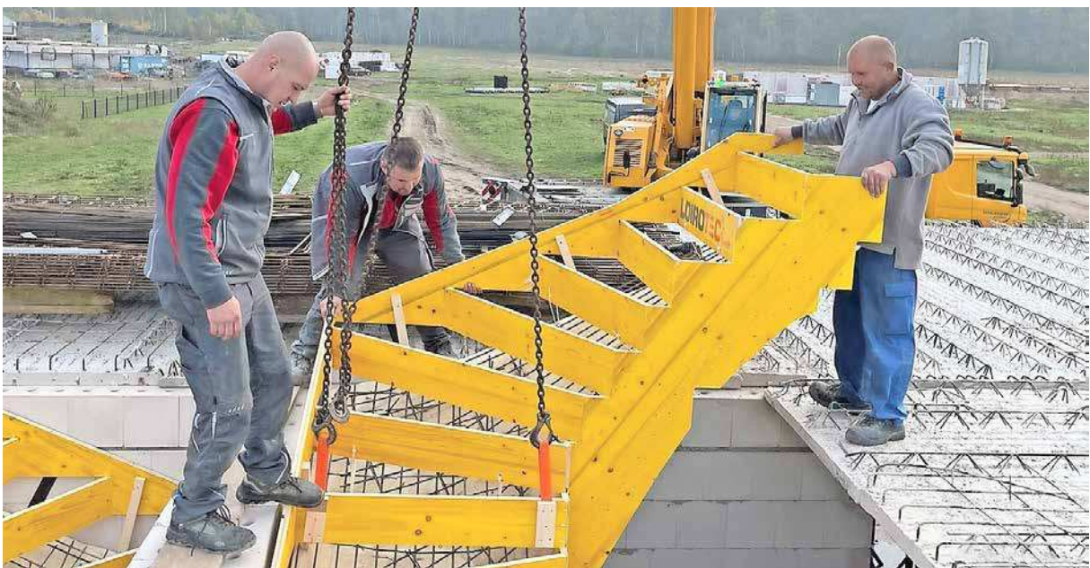
Installation der Treppenschalung. Dieses System soll Zeit und Geld sparen.
