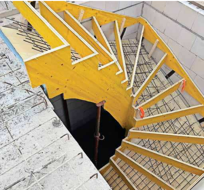
Ansicht von der Installation. 200 bis 300 Kilogramm wiegt so eine Schalung.
