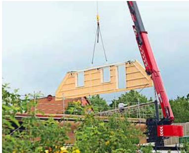
Von der Werkhalle auf die Baustelle: Vorfertigung im Bauhandwerk soll Bauzeit und Kosten senken.
