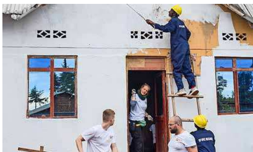
Strahlend weiß sollten Außen- und Innenwände des Gemeindezentrums werden.
