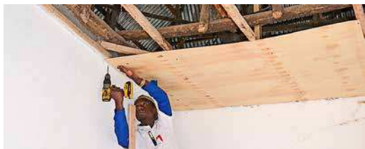
Auch eine Zwischendecke soll das Gemeindehaus erhalten.
