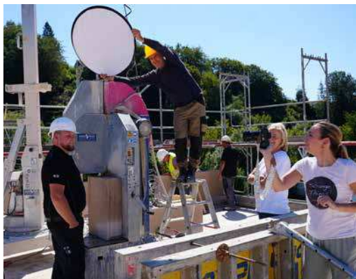
Fotoshooting auf der Baustelle: Maurermeister Lutz Kornowski an seinem Arbeitsplatz.
